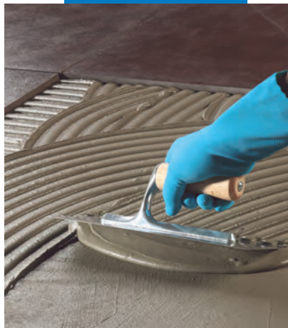
Keraflex Easy felhordása az aljzatra félköríves fogazású simítóval
