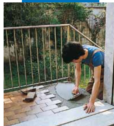
Vízszigetelés, majd kiegyenlítés és burkolás Kerabond T + Isolastic-kal
