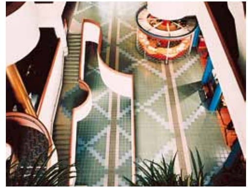
“Porcelain” terméskőlap burkolás Kerabond + Isolastic-kal - Civic Center - North York Ontario (Kanada)
