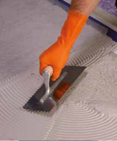
Monolastic első rétegének felvétele új esztrichre Mapetex Sel erősítéssel
