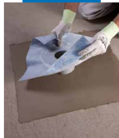
Drain Vertical beépítése Mapelastic-ra
