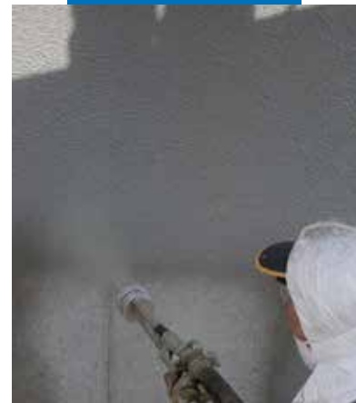
Példa Mapelastic szórásos felhordására viadukon
