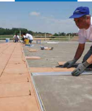
Kerámia burkolólapok fektetése Kerabond + Isolastic keverékkel
