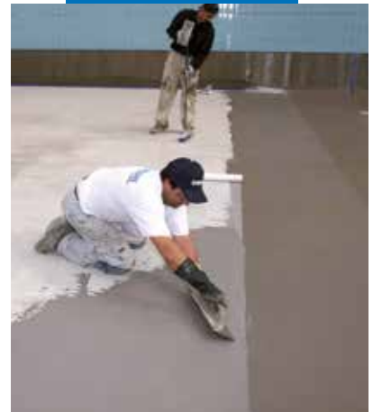
Úszómedence vízszigetelése Mapelastic-kal
