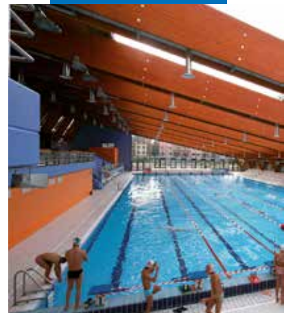
Mapelastic-kal vízszigetelt úszómedence; Scarioni szabadidőközpont - Milánó - Olaszország
