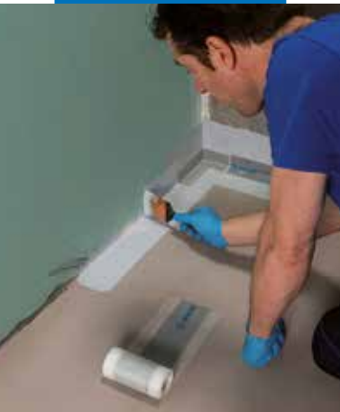
Mapeband PE 120 szalag elhelyezése Mapegum WPS-sel
