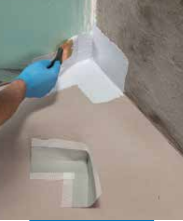
Mapegum WPS felhordása falra hengerrel 90°-os Mapeband PE 120 sarokelem elhelyezése Mapegum WPS-sel
