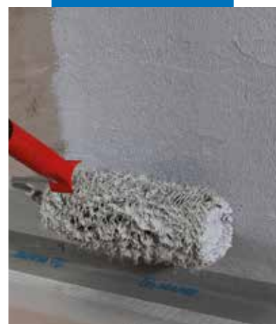
Mapegum WPS felhordása hengerrel Mapegum WPS
