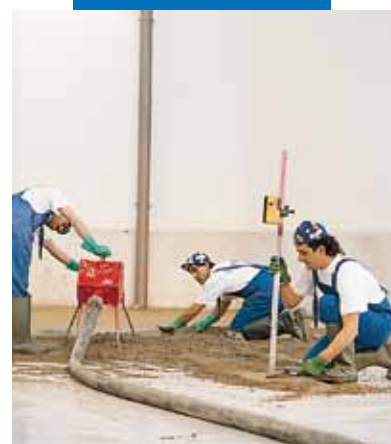
Topcem esztrich bedolgozása
