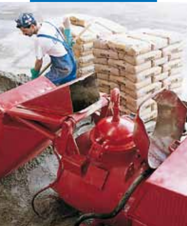
Topcem bekeverése automata esztrichkezővel
