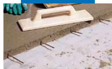
Acélrudakkal erősített Topcem esztrich részlete
