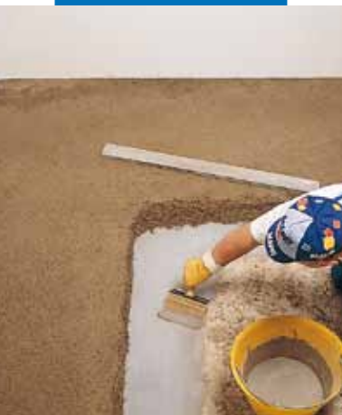
Tapadóhíd felhordása Topcem-mel készített kötött esztrich alá
