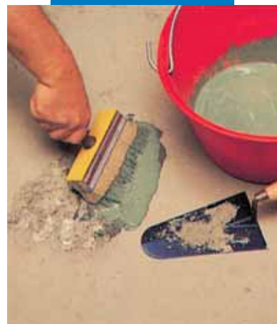
Padlójavítás: a tapadóhíd felhordása
