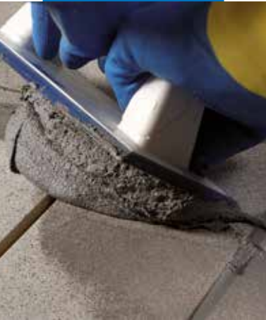
Kerapoxy CQ terítése MAPEI simítóval
