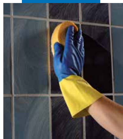
Tisztítás és felületképzés kemény cellulózsivaccsal
