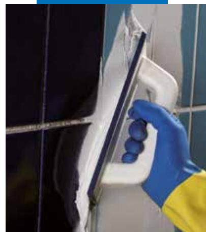
Falburkolat fugázása MAPEI simítóval
