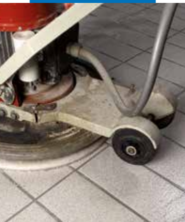
Kerapoxy CQ letisztítása Scotch-Brite® súrolófilc- koronggal ellátott centrális egyfejű csempetisztító-géppel
