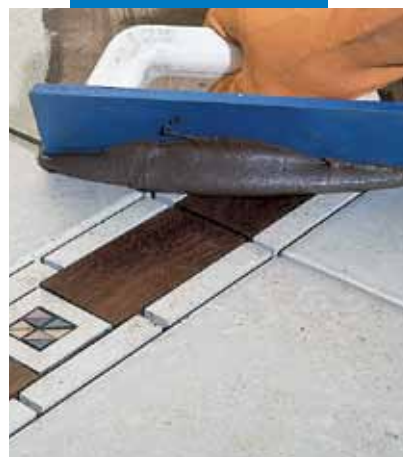
Faberakásos kerámia padlóburkolat fugázása simítóval
