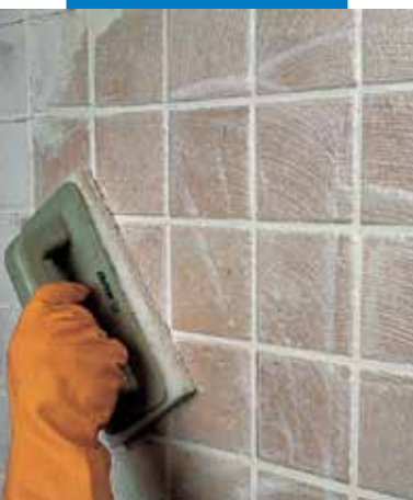
Egyszer-égetett falburkolat tisztítása Scotch-Brite® súrolószivaccsal
