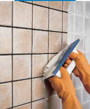
Egyszer-égetett falburkolat fugázása simítóval
