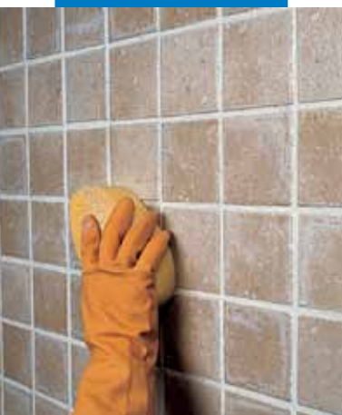
Egyszer-égetett falburkolat tisztítása szivaccsal
