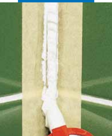
Mapesil AC felhordása
