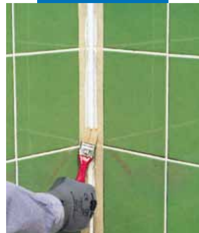
Hézagkitöltés simítása szappanos vízzel és kis ecsettel
