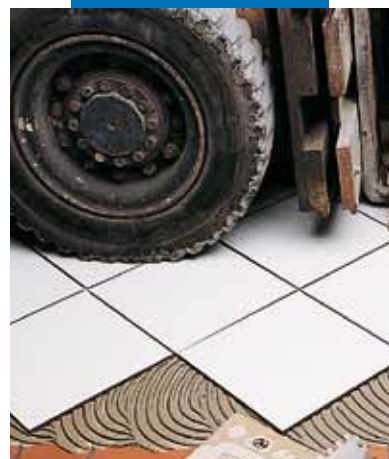
Aszfalt ipari padló gyors burkolása
