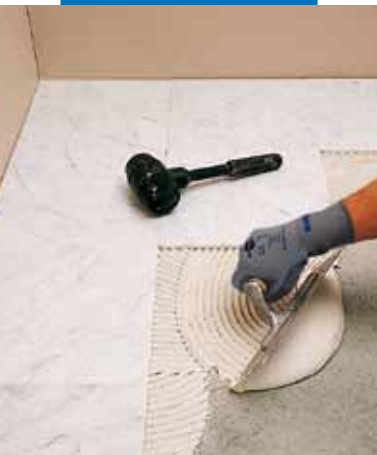
Fehér Carrara márvány fektetése fehér Keraquick S1-kel
